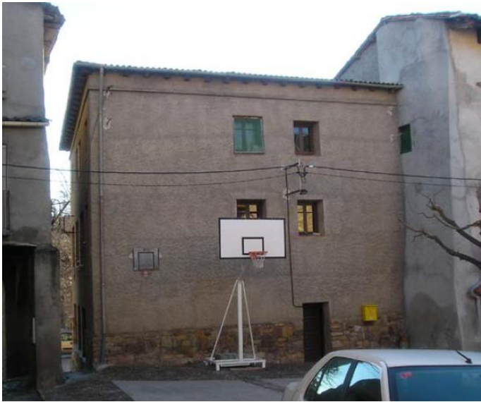
Façana nord estat actual
