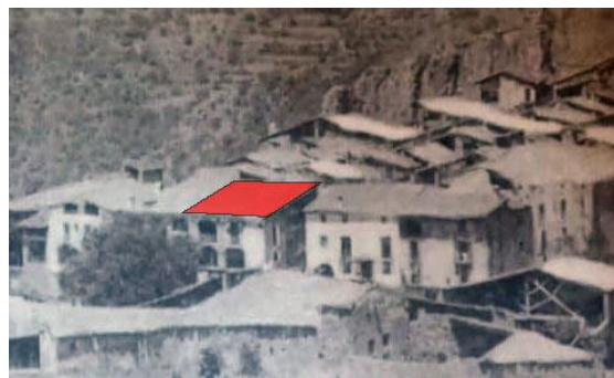
S'hi pot observar la volumetria de l'antiga Casa de la Vila, amb una coberta a una aigua, cap la plaça. Es la tipologia de coberta tipus de la majoria de cases del poble: cobertes a una aigua i ràfec horitzontal al carrers principals.
