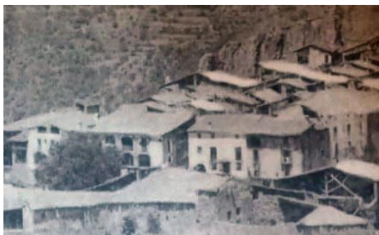
S'hi pot observar la volumetria de l'antiga Casa de la Vila, amb una coberta a una aigua, cap la plaça. Es la tipologia de coberta tipus de la majoria de cases del poble: cobertes a una aigua i ràfec horitzontal al carrers principals.
